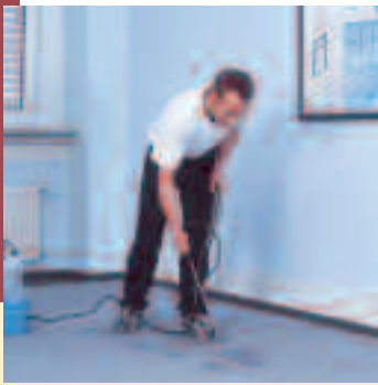
Nebelfeuchtes Auftragen des tensidfreien FDT®-Enzymreinigers mit Protectin®
